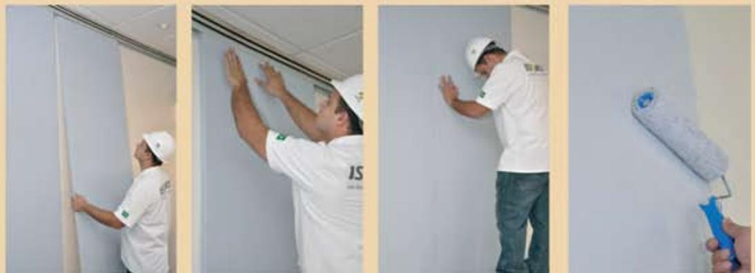
1. Após a fixação dos perfis "J" superior e inferior na parede, encaixar o painel entre os perfis metálicos.
