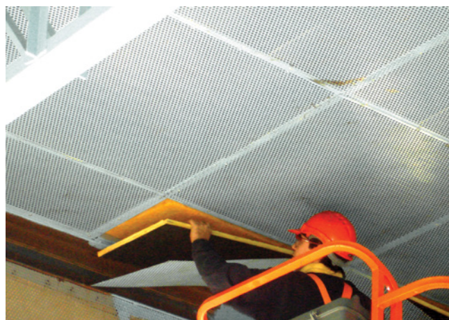
Utilización de andina Isocoustic detrás de bandejas perforadas.
