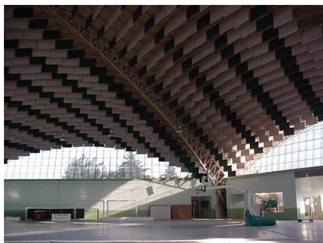
Utilización de andina Isocoustic como baffles (2 paneles/baffle).
